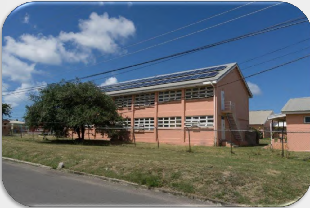
500kw Solar System Antigua year 2017
